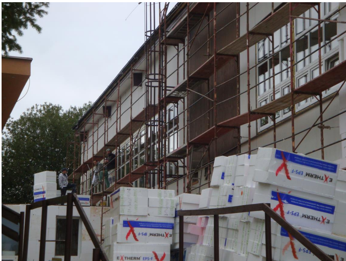
... zahájení zateplování tělocvičny na domově mládeže ...
