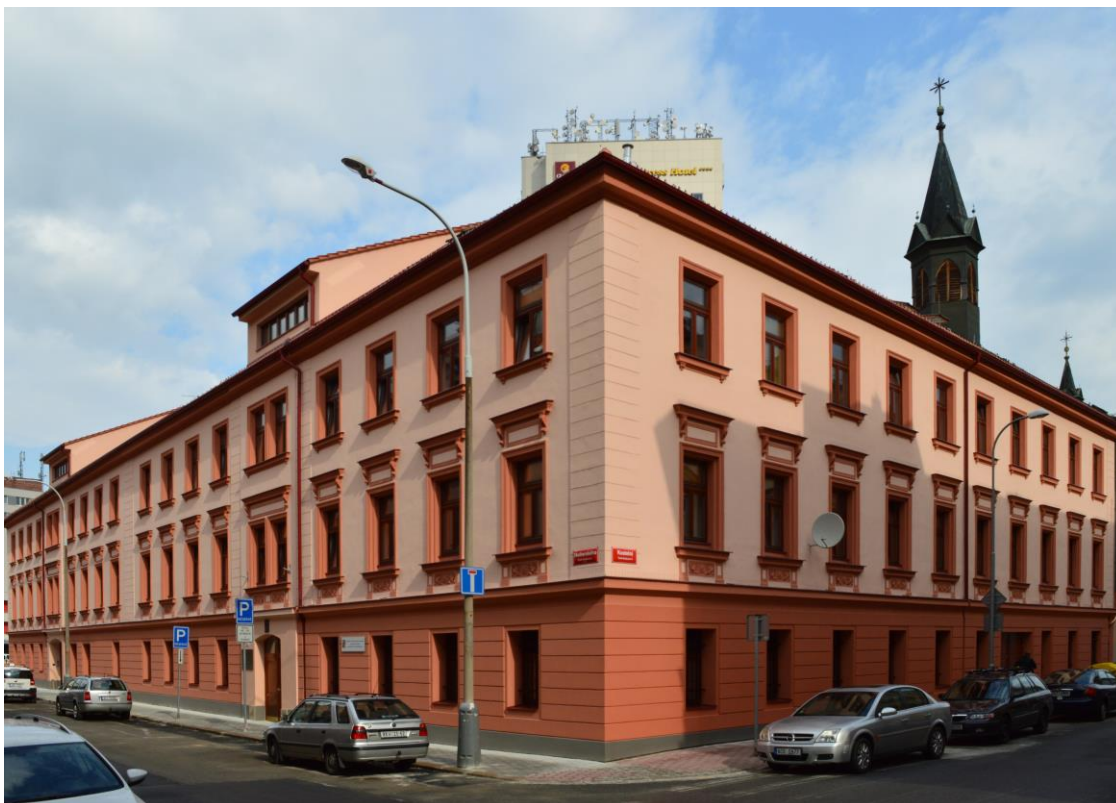
... na závěr rekonstrukce škola získala novou fasádu ...
