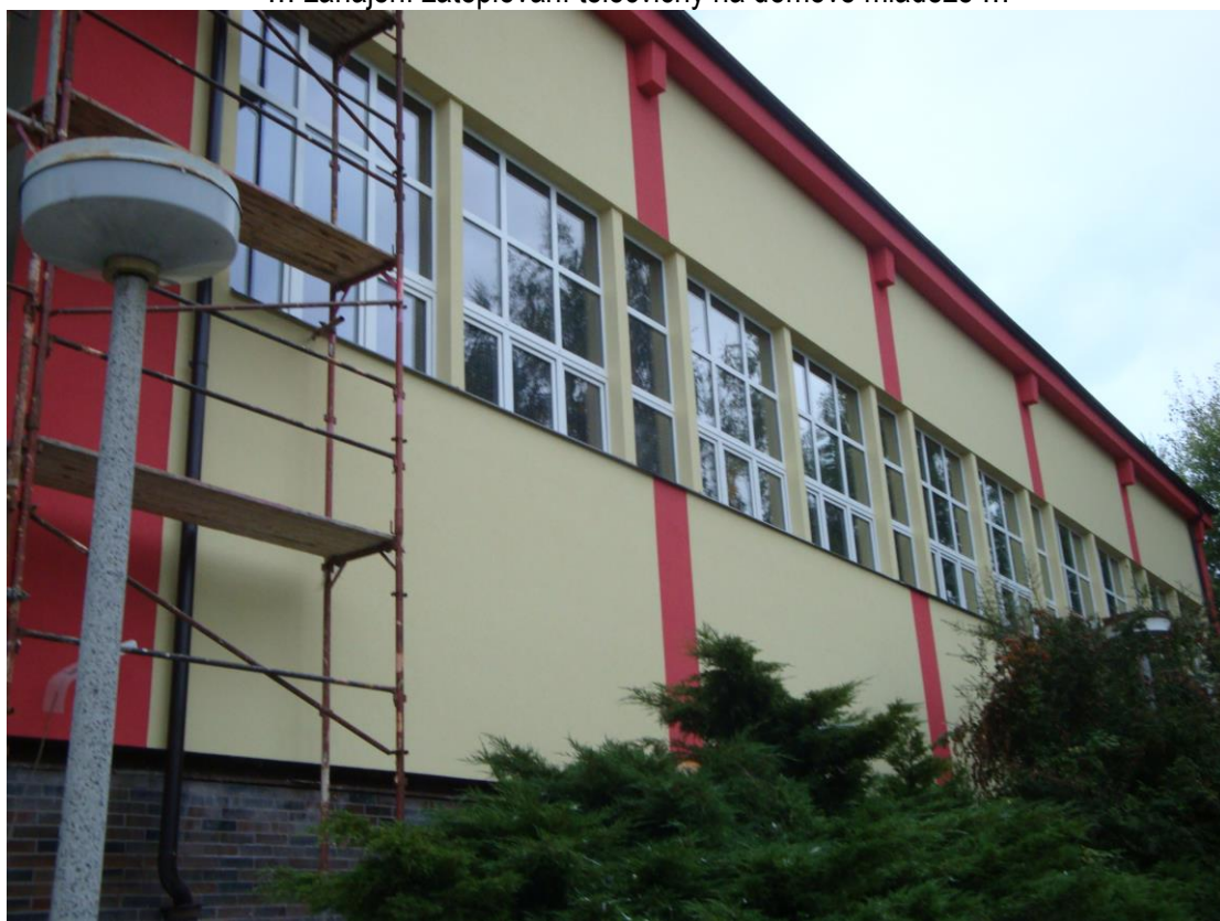
... ukončení zateplování tělocvičny na domově mládeže ...
