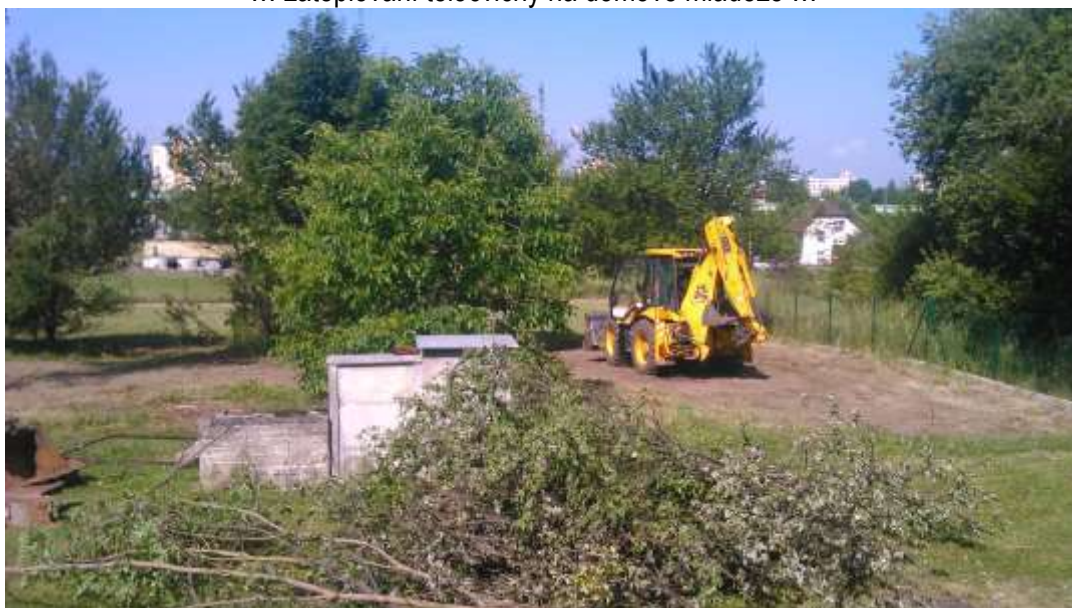
... úprava ploch v objektu Domova mládeže ...
