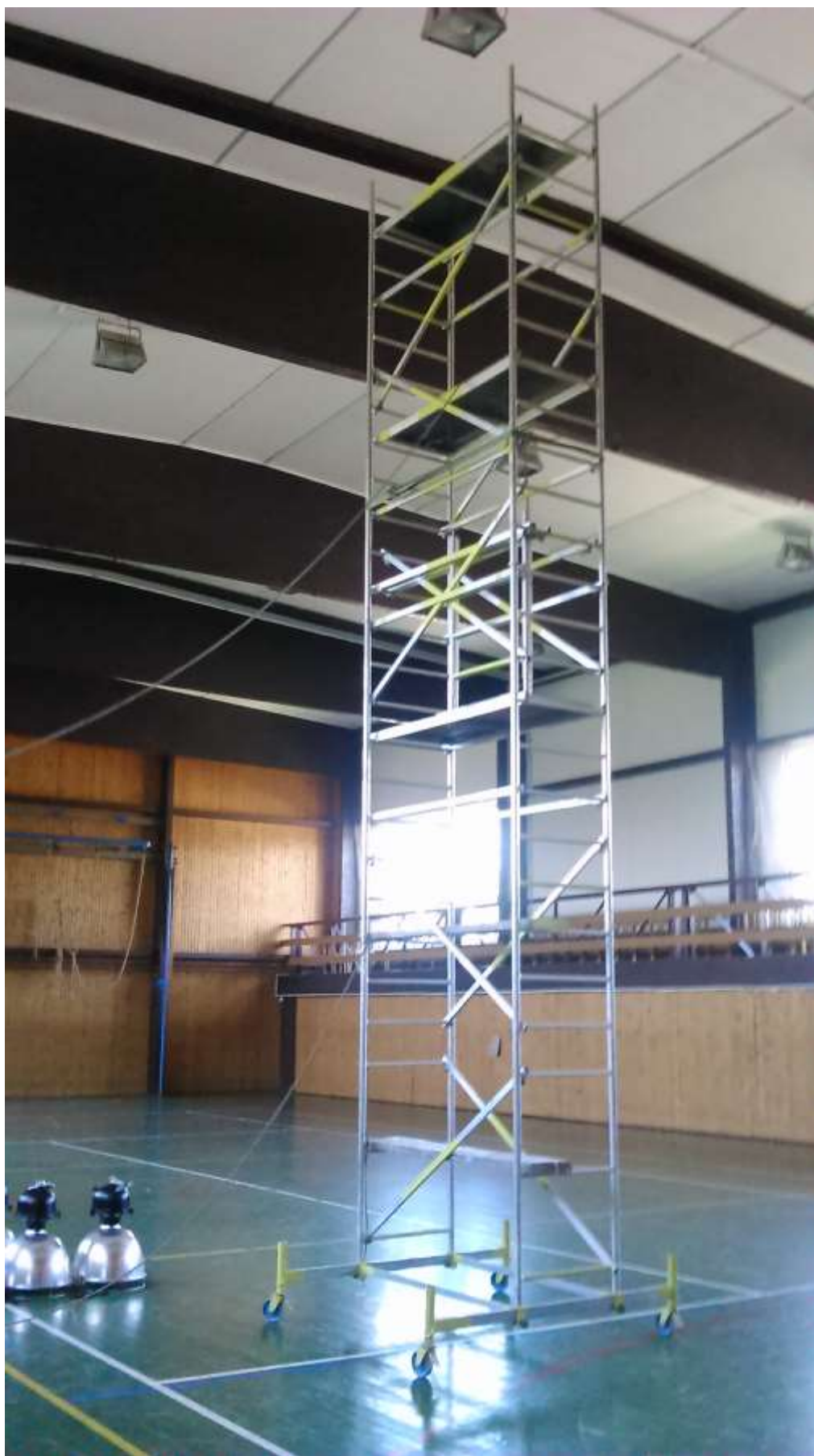
... rekonstrukce osvětlení v tělocvičně v objektu domova mládeže ...
