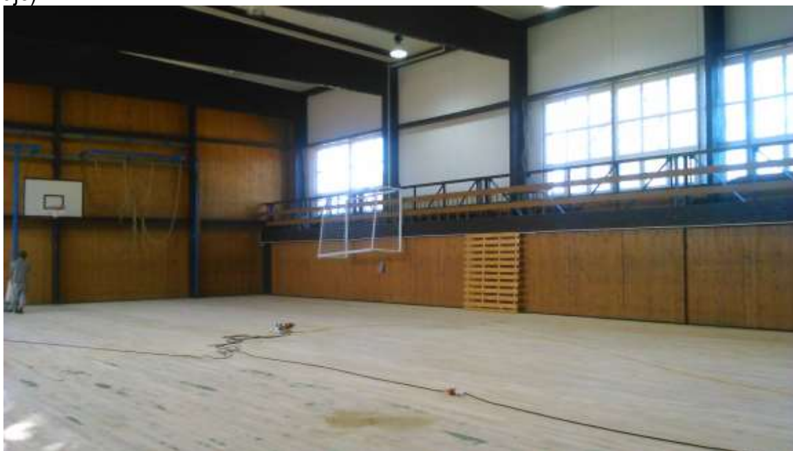
... rekonstrukce podlahy tělocvičny na domově mládeže ...
