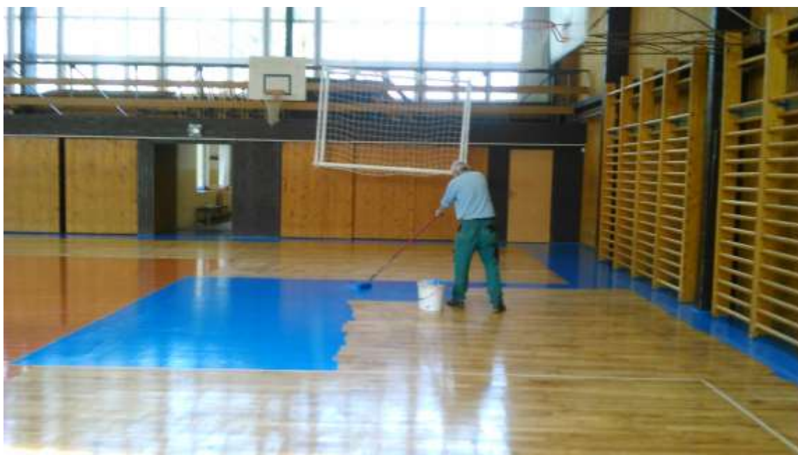
... rekonstrukce podlahy tělocvičny na domově mládeže ...
