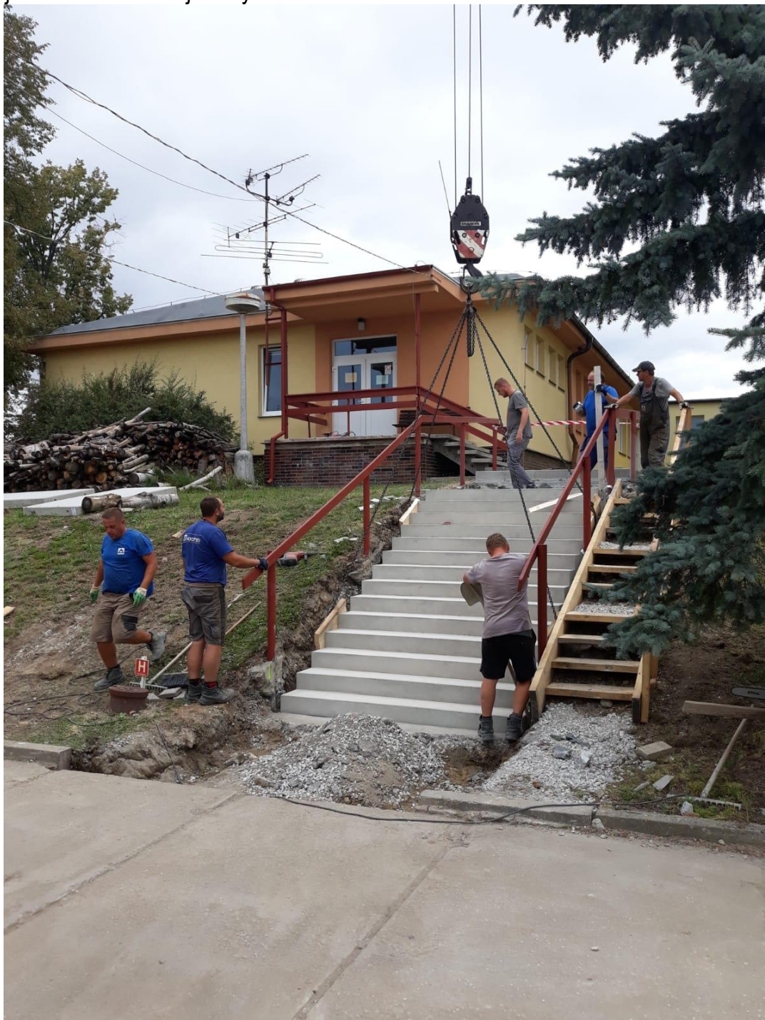
... rekonstrukce schodiště na domově mládeže ...
