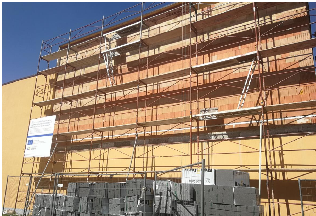
... stavba nové učebny ...
