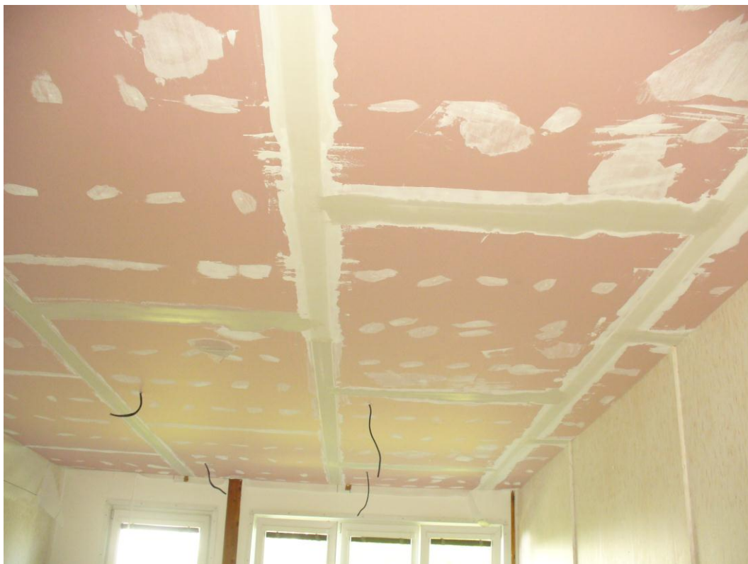
Jeden z pokojů DM – rekonstrukce po krupobití v červenci 2011
