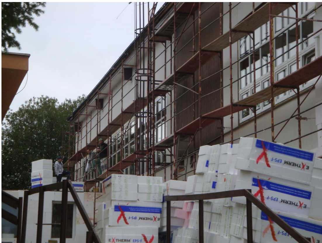
... zahájení zateplování tělocvičny na domově mládeže ...
