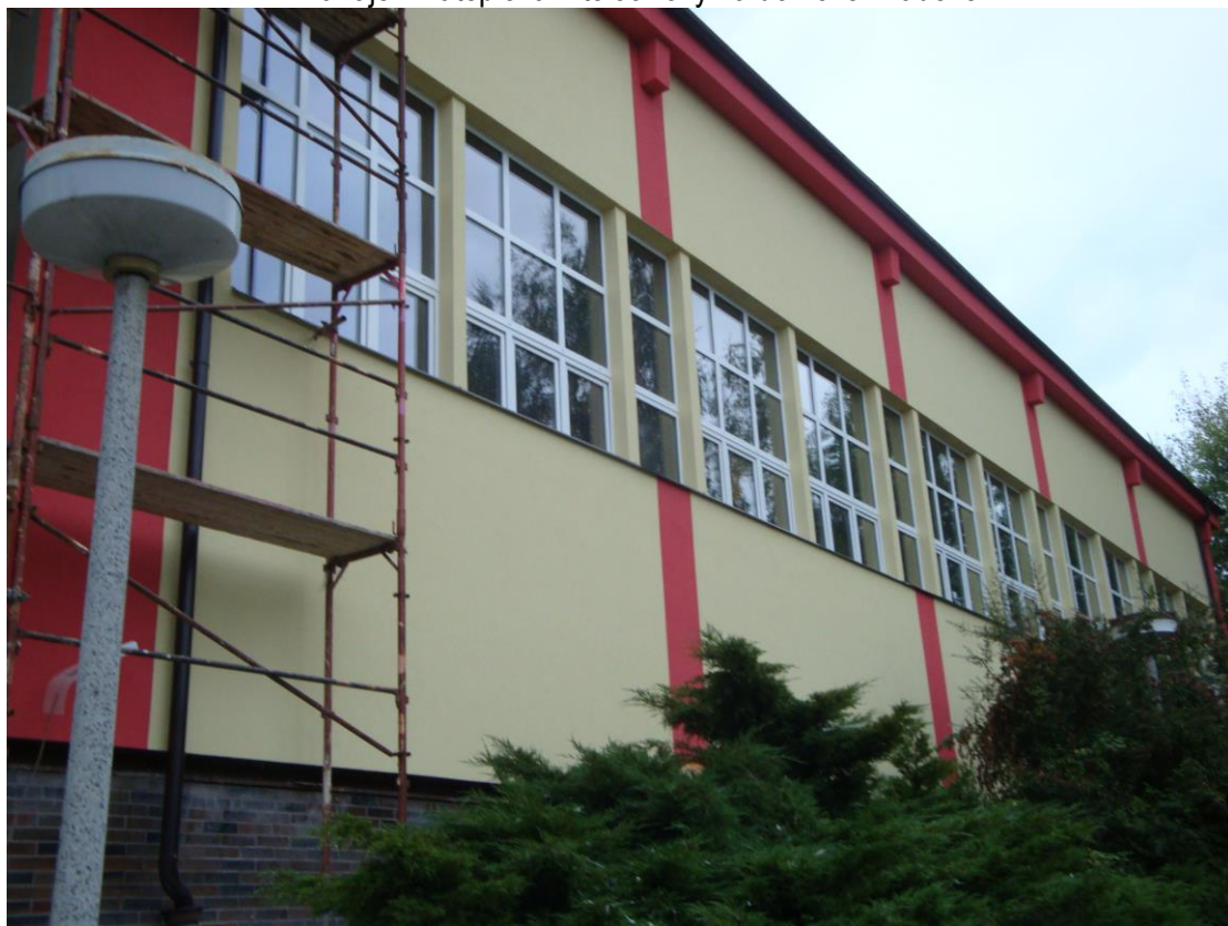
... ukončení zateplování tělocvičny na domově mládeže ...
