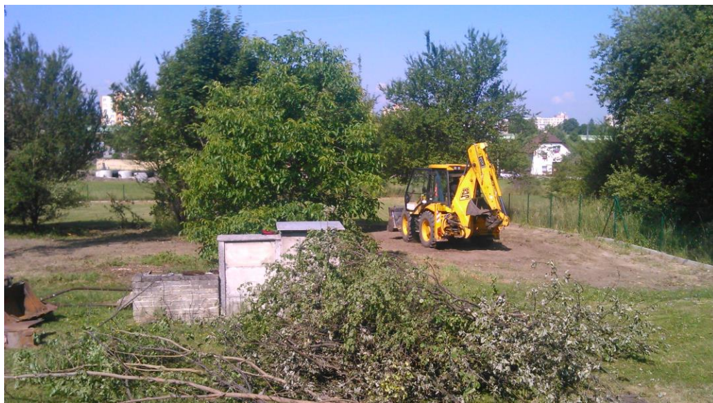
... úprava ploch v objektu Domova mládeže ...
