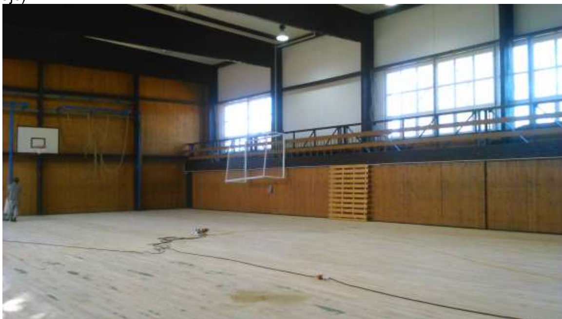
... rekonstrukce podlahy tělocvičny na domově mládeže ...
