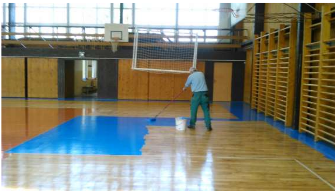
... rekonstrukce podlahy tělocvičny na domově mládeže ...
