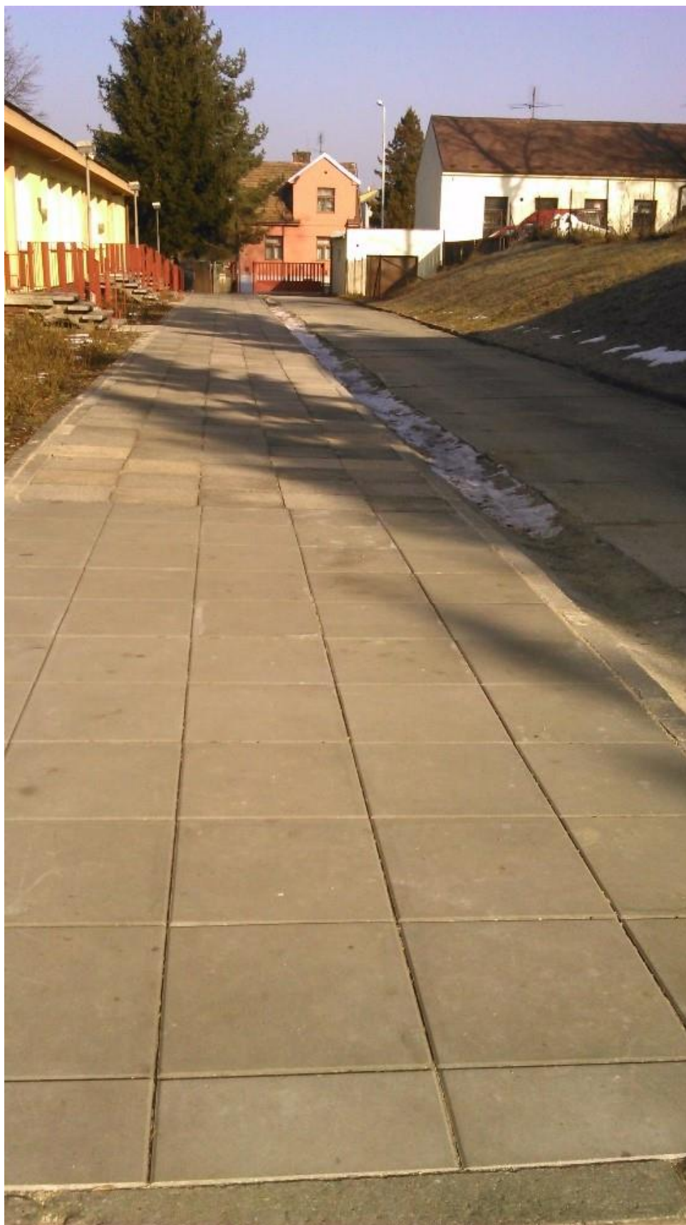
... rekonstrukce chodníku na domově mládeže ...
