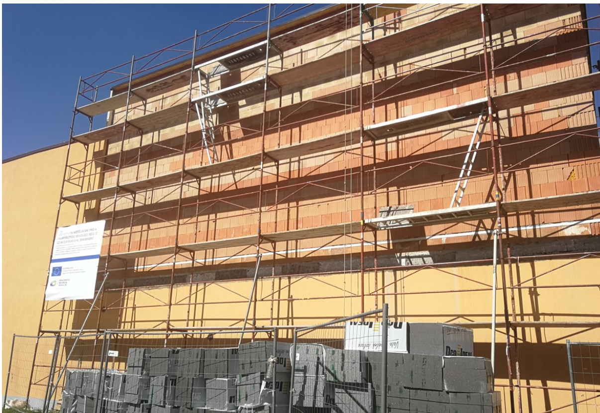
... stavba nové učebny ...
